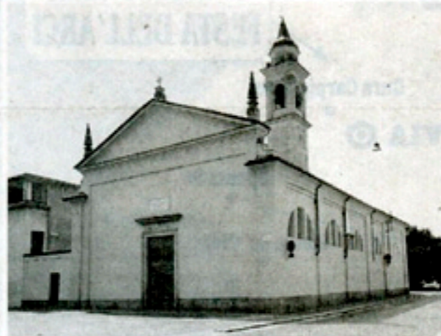
La chiesa di San Rocco a Voghera
