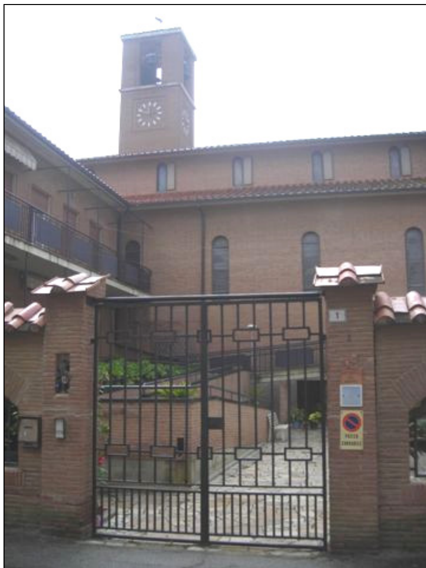
La chiesa di San Rocco a Marina di Grosseto
